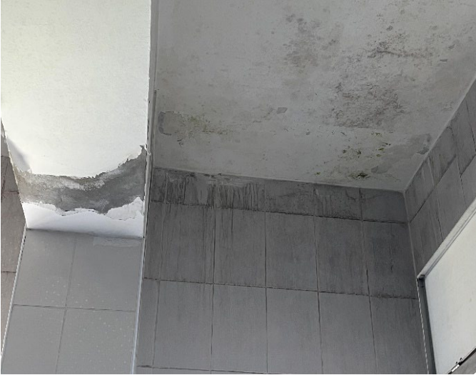
Şekil 2. Nemli yüzey ve küf (orijinal)
